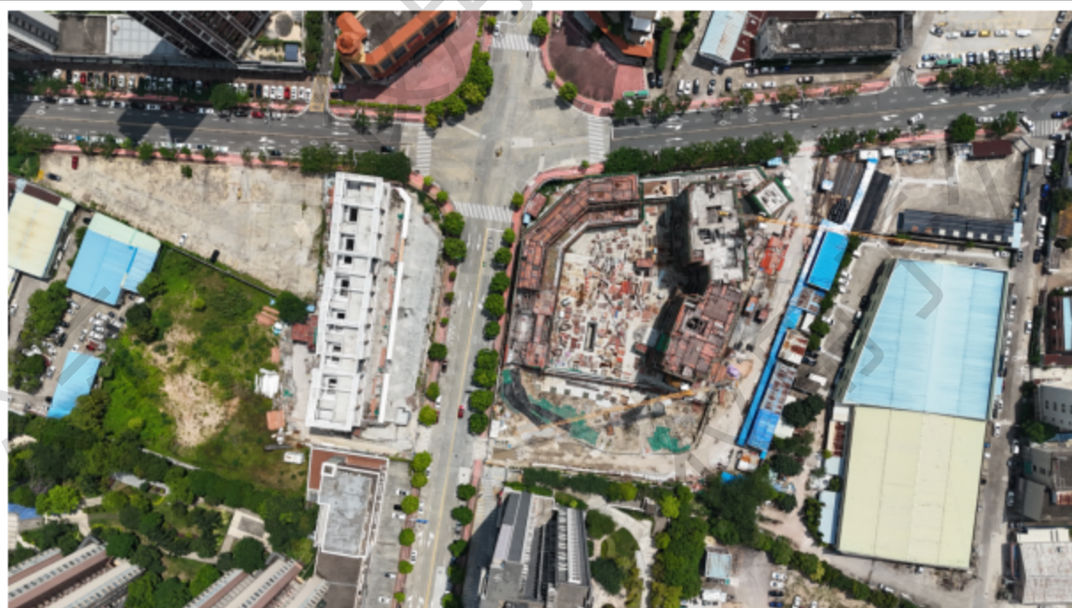
项目航拍图（拍摄时间：2026 年 7 月）
